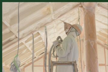
吹付ウレタン断熱工法にて、屋根 230 mm・外壁 140 mmを施工。ウレタンは無数の細かい気泡の中に多量の空気を含んでいるため、ダウンジャケットやセーターと同じように、優れた断熱性が高いのが特徴です。
