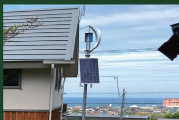
地階の電力をまかなう、太陽光と風力を使った、発電装置を搭載しています。風力発電は、わずか秒速3mの風で発電ブレードが回転し発電できるように特殊な形状をしています。
